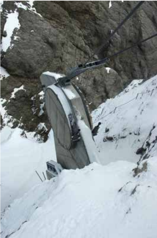
Pollerscheibe mit Seilablenkung, Seite Bergstation „Ice-Flyer“.
