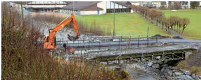
Das neue Brückenprovisorium über die Engelberger Aa Richtung Bänklialp steht (Foto: Charles Christen).
