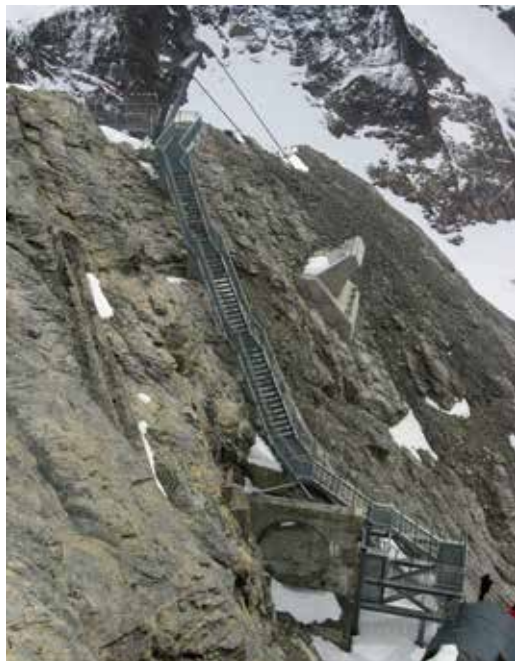
Pylon, Verankerung und Treppenturm, Seite Südwandfenster. Wegen des Permafrostes mussten Bohrlöcher und Beton der Felsanker beheizt werden.
