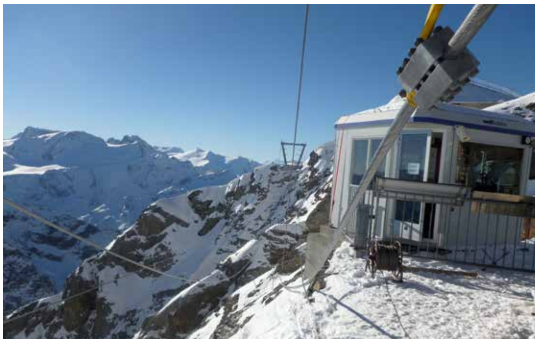
Seilzug – per Helikopter wurde das Windenseil von Pylon zu Pylon gezogen, am Windenseil wird danach das Tragseil über den Abgrund gezogen. Blick von der Bergstation „Ice-Flyer“ zur Seite Südwandfenster.
