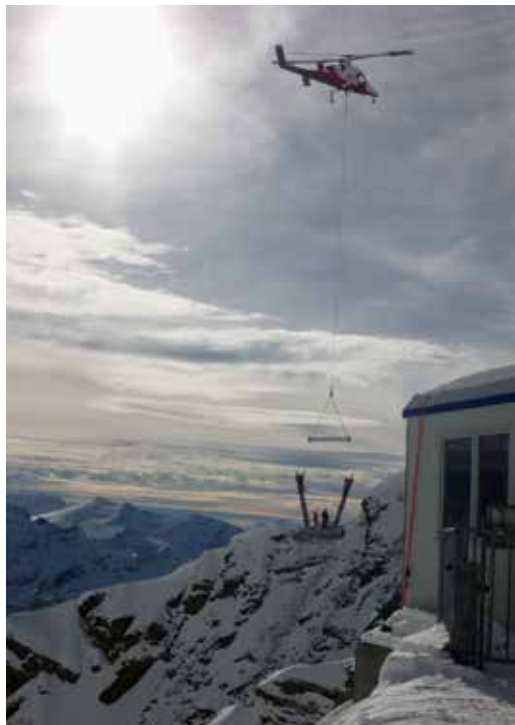
Getragen wird die Hängebrücke von zwei Pylonen. Aufbau Pylon, Seite Südwandfenster: Der Querträger wird per Helikopter montiert.
