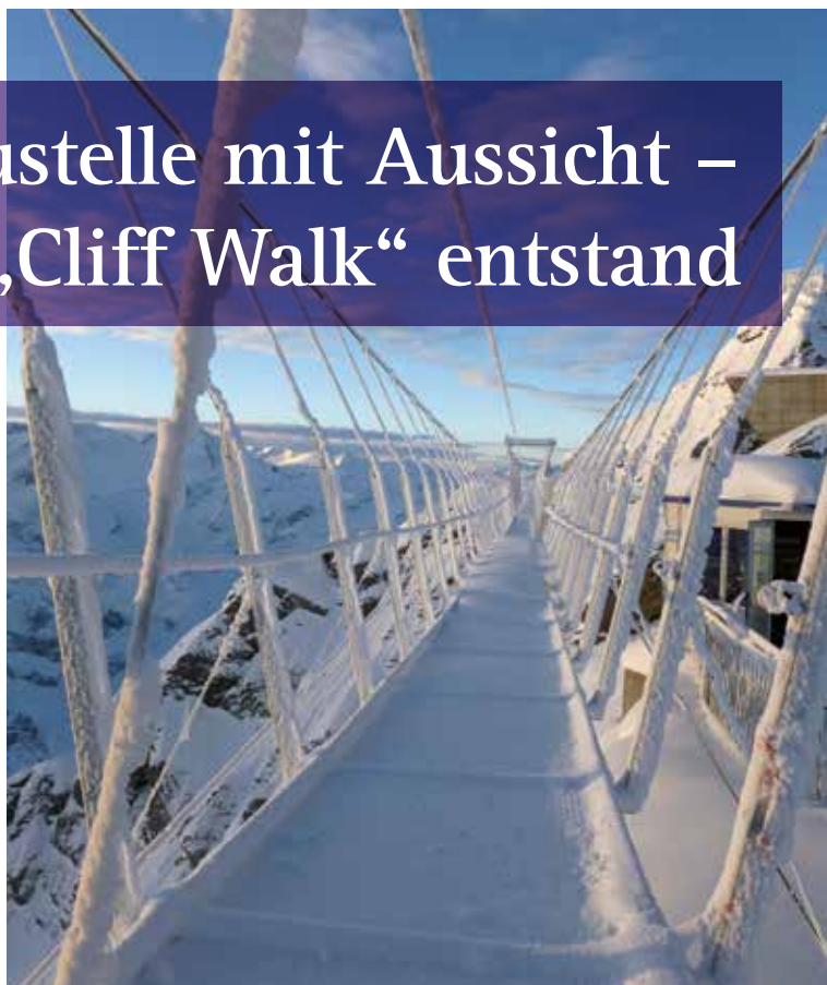
Die Hängebrücke an einem kalten Wintermorgen, kurz vor Abschluss der Arbeiten.
