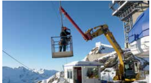
Die für die weiteren Arbeiten notwendigen Montagekarren werden in die Tragseile eingehängt.
