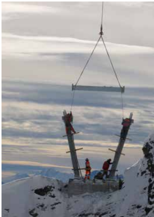
Getragen wird die Hängebrücke von zwei Pylonen. Aufbau Pylon, Seite Südwandfenster: Der Querträger wird per Helikopter montiert.
