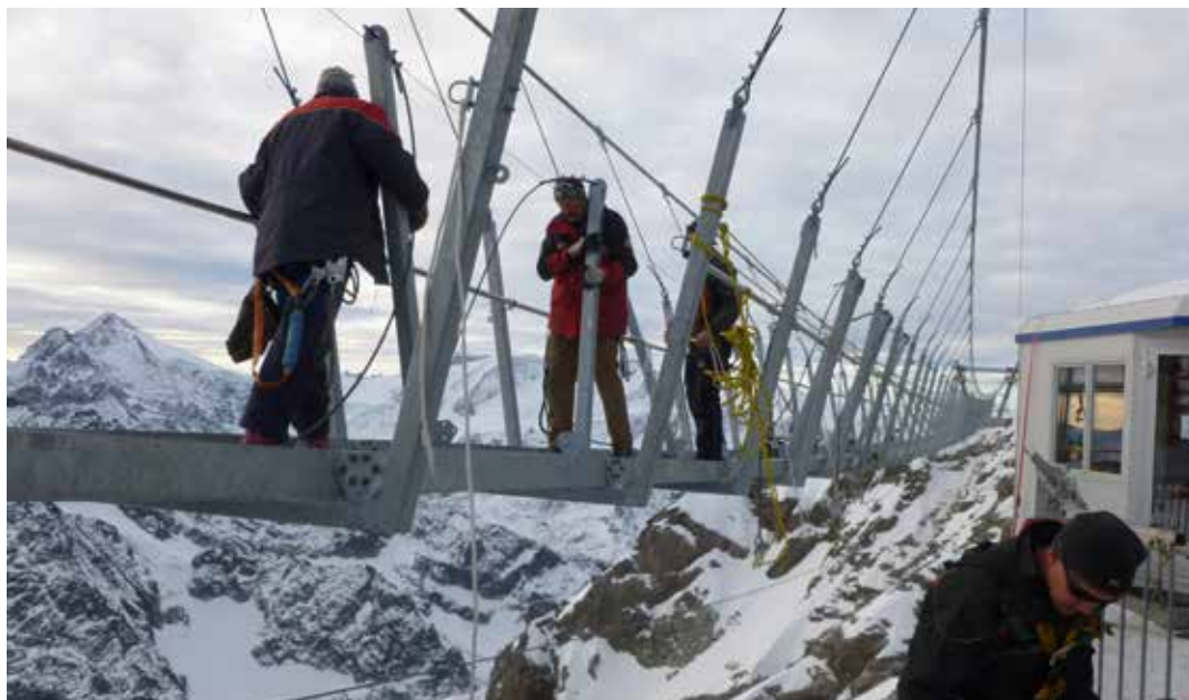
Hängermontage, Seite Bergstation „Ice-Flyer“: Die U-förmigen Bügel der Hänger-Elemente werden über die bereits fertiggestellte Konstruktion bis zum „Brückenkopf“ bei den Montagekarren gerollt. Sämtliche Arbeitskräfte vor Ort sind gesichert.
