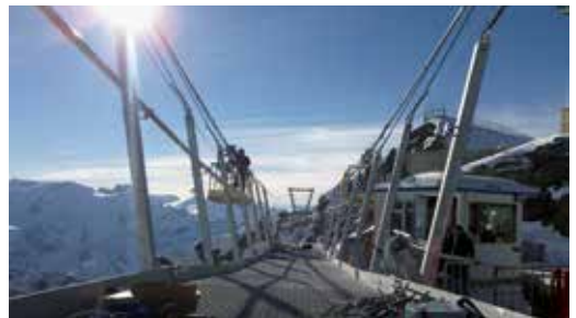
Die Hänger-Elemente, auf denen die Gitterroste der Brücke zu liegen kommen, werden mit diesen speziell konstruierten Montagewagen vor Ort gebracht und montiert. Dahinter erfolgt der Einbau der Gitterroste.
