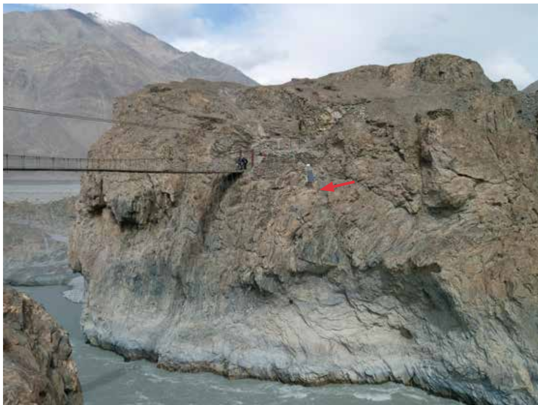
Pegelstation bei der Einmündung des Keleqin-Rivers in den Yarkant. Eine Solaranlage (roter Pfeil) versorgt die Station mit Energie.
