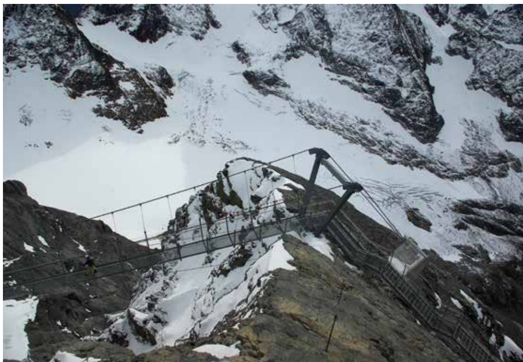
So präsentiert sich der „Cliff Walk“ heute abenteuerlustigen Gästen. Rechts der Treppenturm, der vom Südwandfenster zur Hängebrücke hinaufführt, und die Verankerung.
