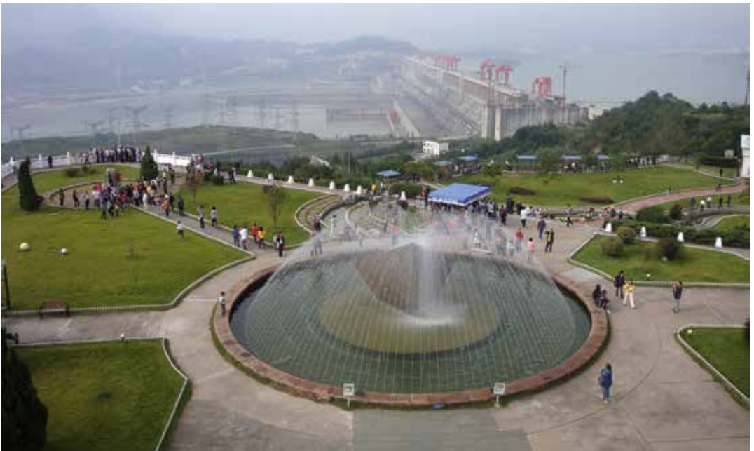
Abb 9: Der Dreischluchtdamm staut den Yangtze Fluss auf einer Breite von drei Kilometern etwa 120 Meter hoch. Durch den Aufstau ist ein See von über 660 km Länge entstanden. Der Damm dient dem Hochwasserschutz, der Energieproduktion und der Schifffahrt.
