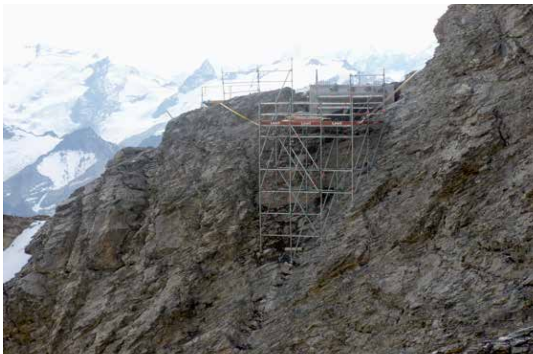
Die Gerüstkonstruktion für den Bau der Fundamente der Hängebrücke, Seite Südwandfenster.
